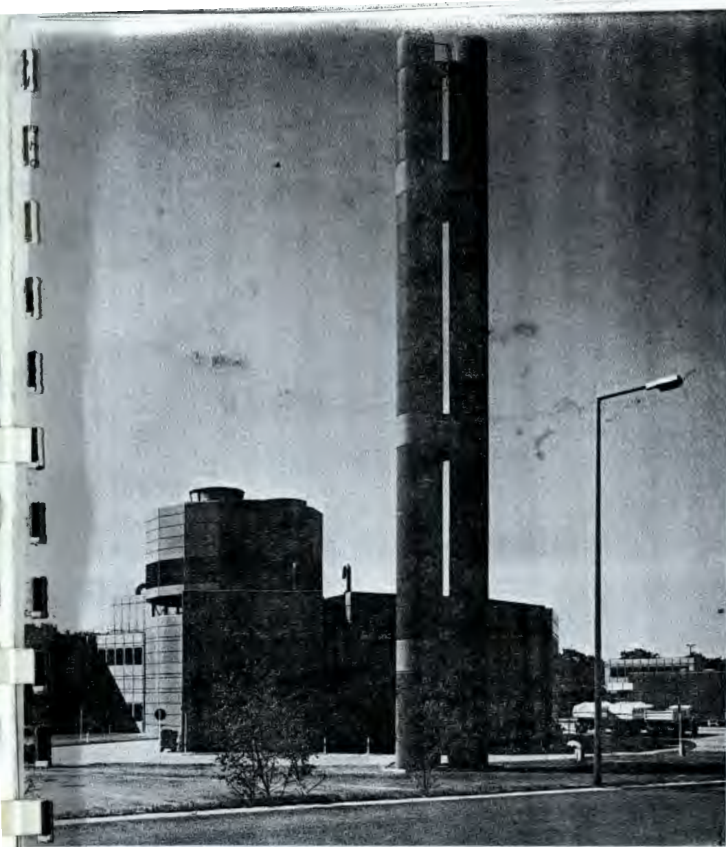
37 Energiezentrale mit Schornsteingruppe. Rückkühlwerk auf dem Dach.
